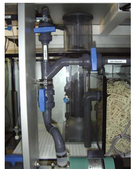
Ordentlich verlegte PVC-Rohre bieten ein Höchstmaß an Übersichtlichkeit und Sicherheit. Foto: AquaCare
